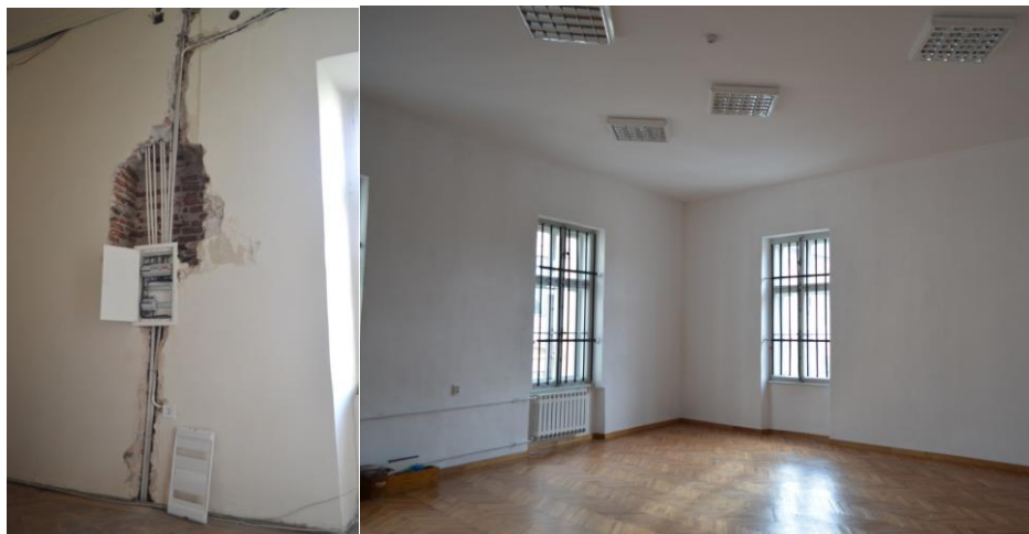
Imagini din spațiile de depozitare și pentru laboratoarele de restaurare, în curs de amenajare.
