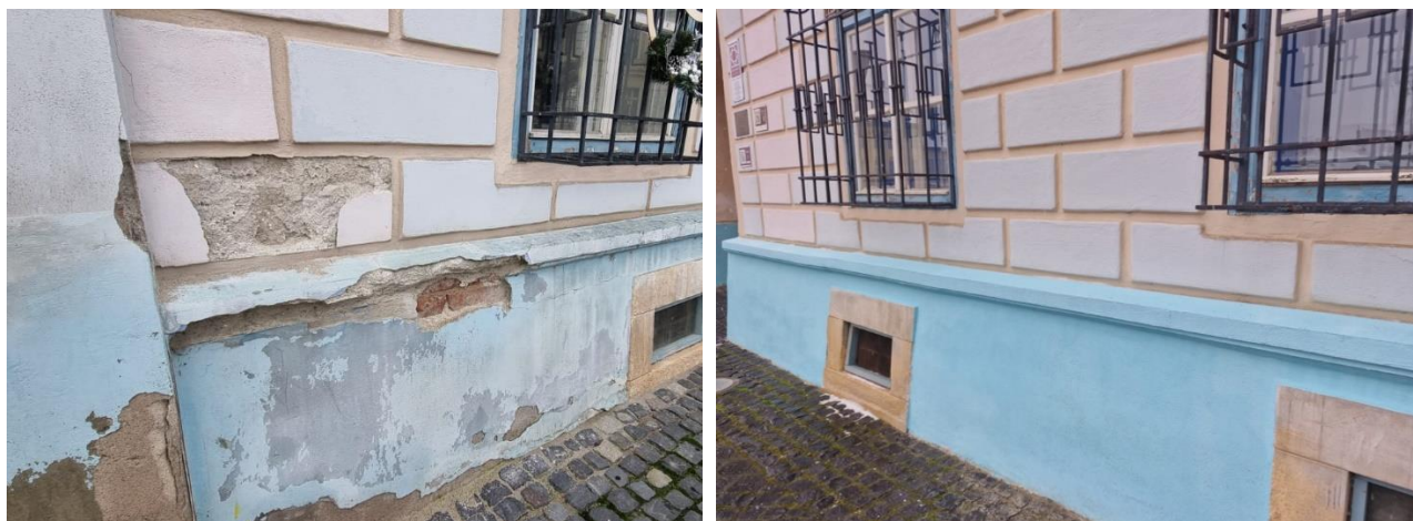
Soclu fațadă Casa Albastră (înainte și după reparații)
