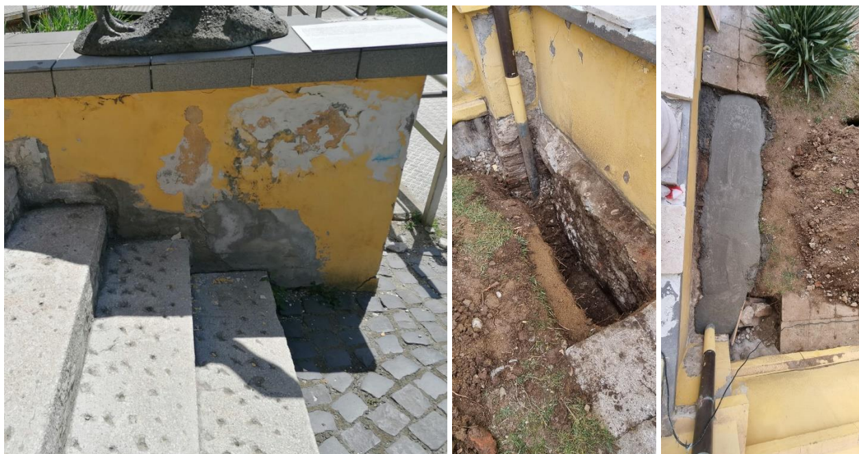
Reparații subzidire scări
