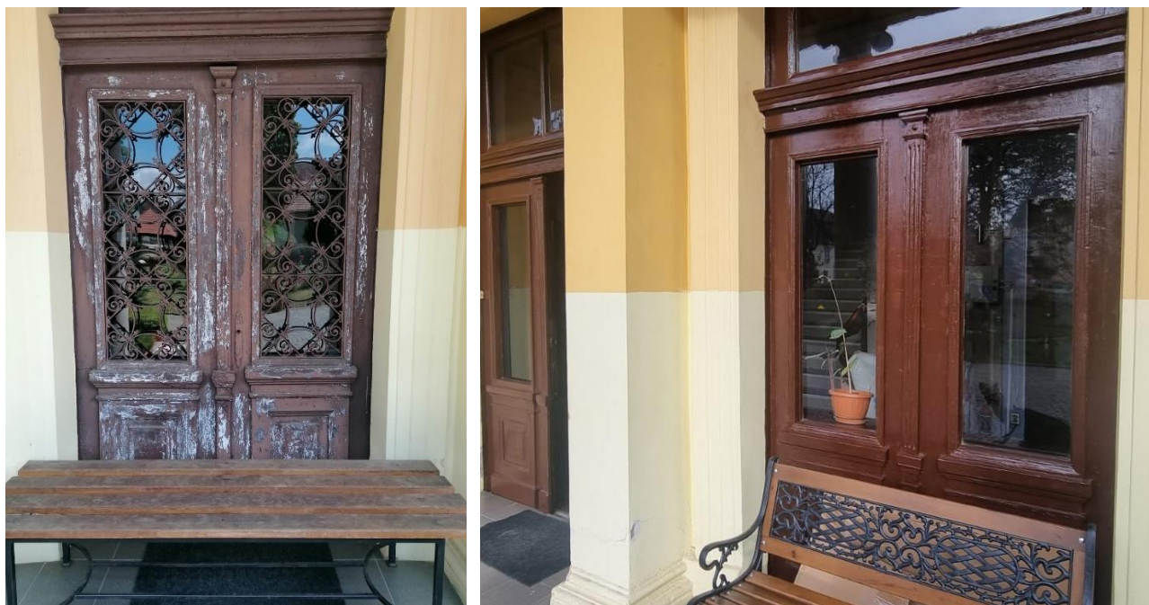
Uși fațadă, parter (înainte și după recondiționare)
