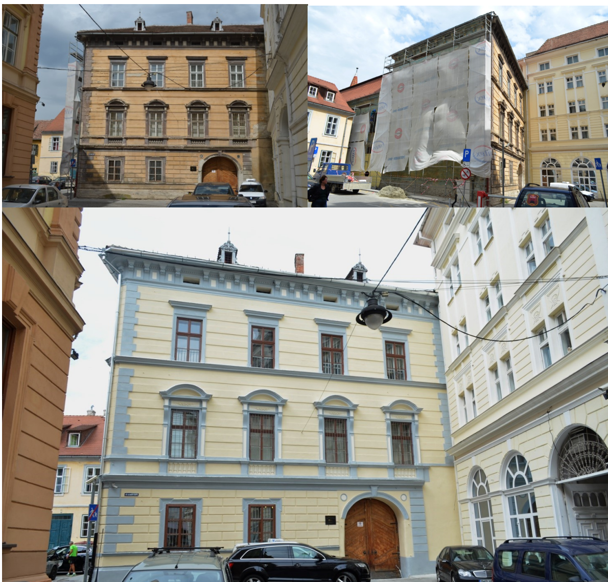
Fațada secundară a palatului Brukenthal înainte de reabilitare, în timpul lucrărilor și după reabilitare.
