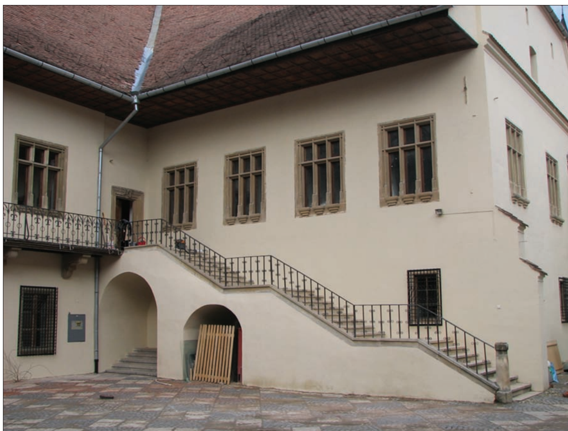
Lucrări de reabilitare, curtea interioară a Muzeului de Istorie Casa Altemberger
